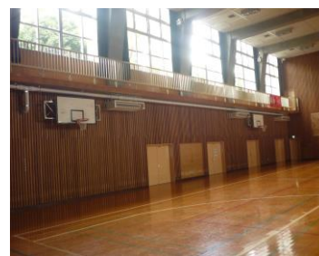
体育館エアコン設置の様子
