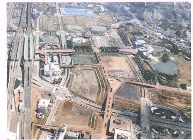
開発中の多摩センター駅周辺
