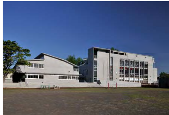
※建替え工事の完了した多摩第一小学校※
