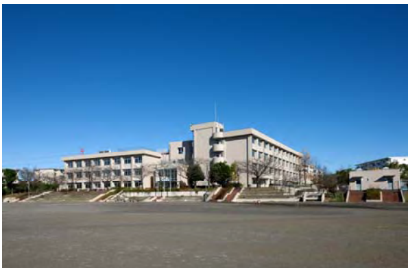
※増改修工事の完了した青陵中学校※
