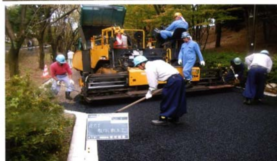
【道路工事（透水性舗装）風景】
