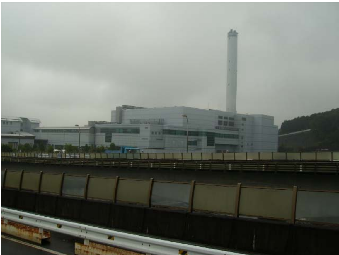
【多摩ニュータウン環境組合 多摩清掃工場】
