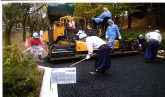
【道路工事（透水性舗装）風景】
