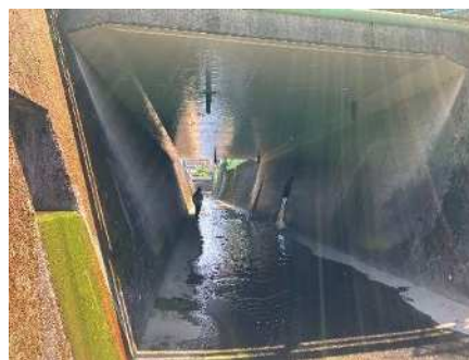
唐木田方面水路下流側 (B)
