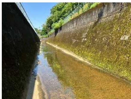
唐木田方面水路上流側 (A)
