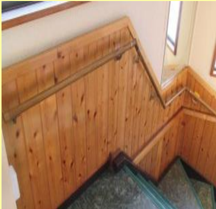
手すり設置工事
