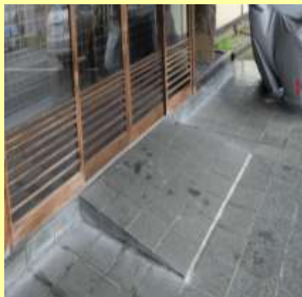
段差解消工事
