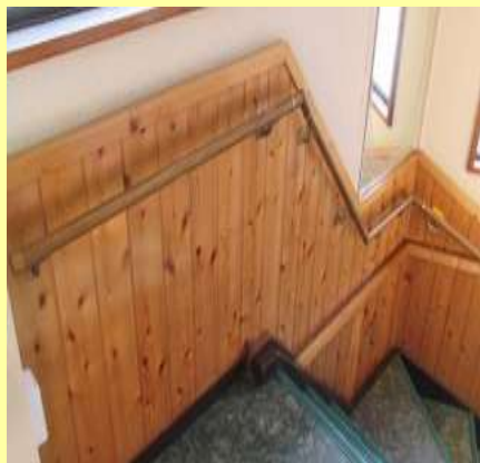
手すり設置工事
