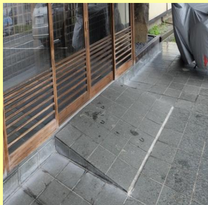
段差解消工事
