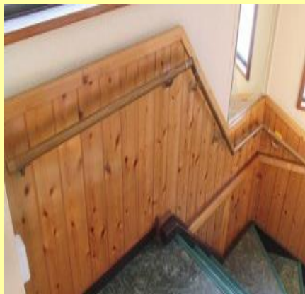
手すり設置工事
