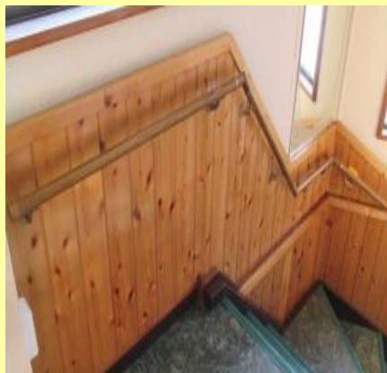
手すり設置工事
