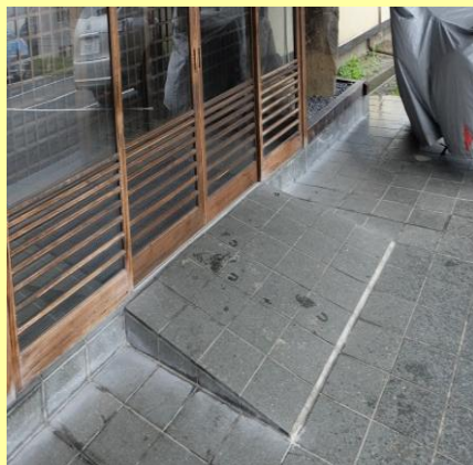
段差解消工事
