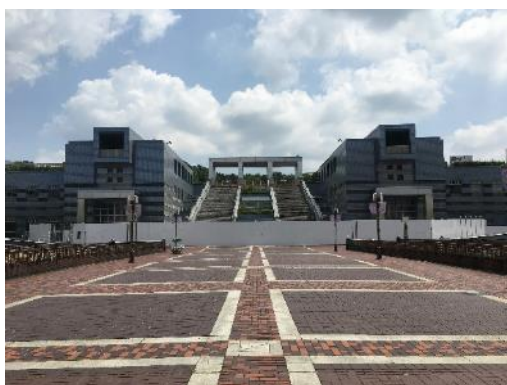
仮囲いが設置された様子
