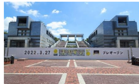
仮囲い設置時の様子
