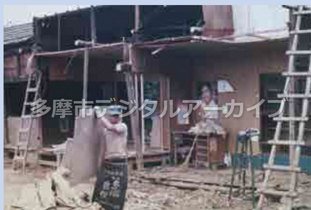
店舗解体作業 1972(昭和47)年6月14日
