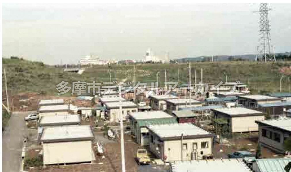
仮住居施設の様子 1979(昭和54)年 山王下地区の仮住居施設は山王下2丁目に設けられた。
