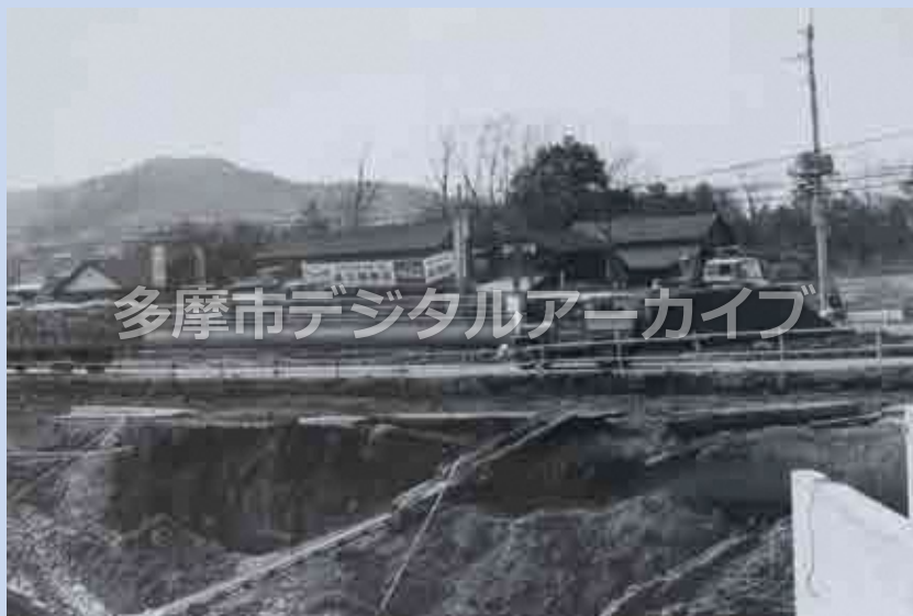
乞田川改修・新大橋建設工事開始 1971(昭和46)年3月
