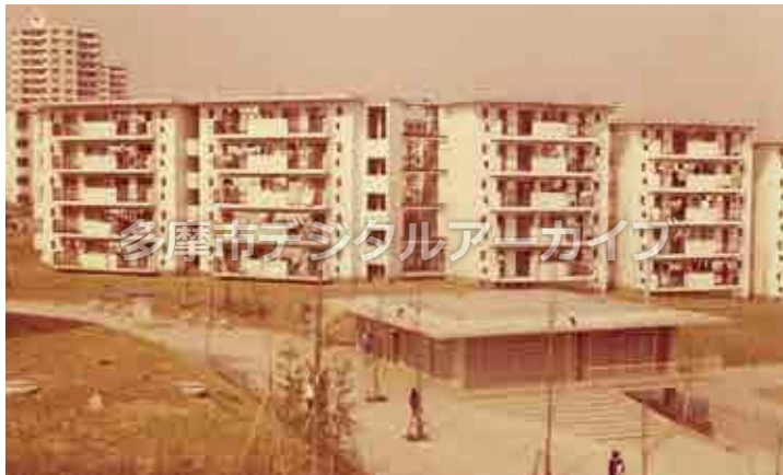
百草団地の外観 1971(昭和46)年3月 この団地は、和田に1970(昭和45)年3月に建設され、間取りは2DK～3DKとなっている。
