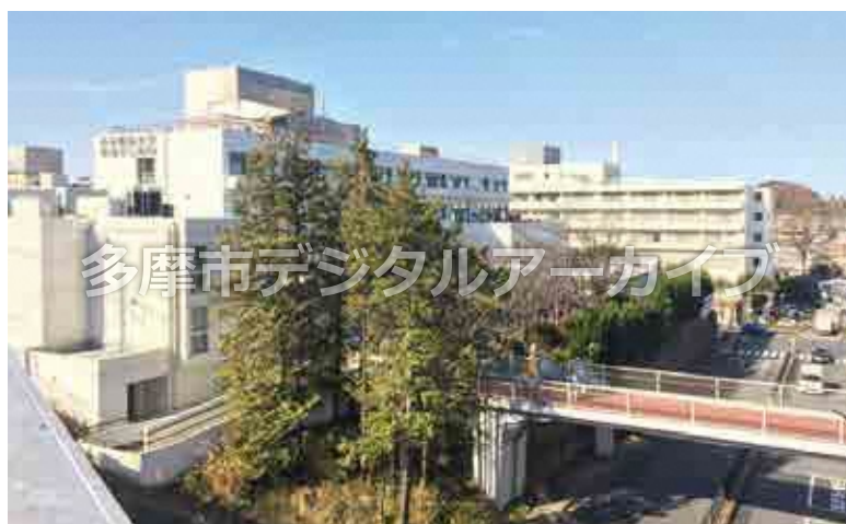
建設中の日本医科大学付属 多摩永山病院B棟（写真右側） 1982（昭和57）年頃
