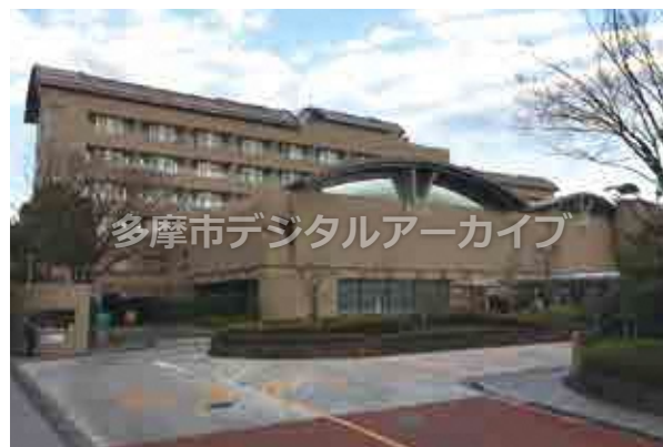
多摩南部地域病院本館 2019（令和元）年12月
