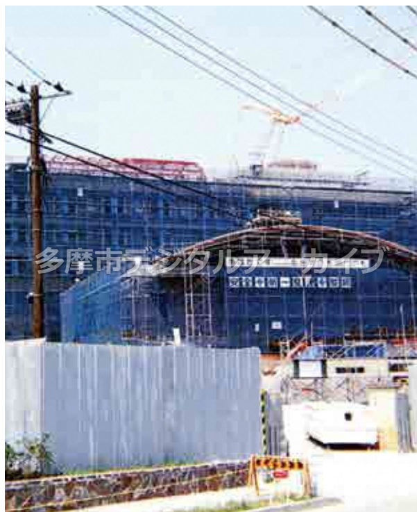
建設中の多摩南部地域病院本館 1992（平成4）年10月
