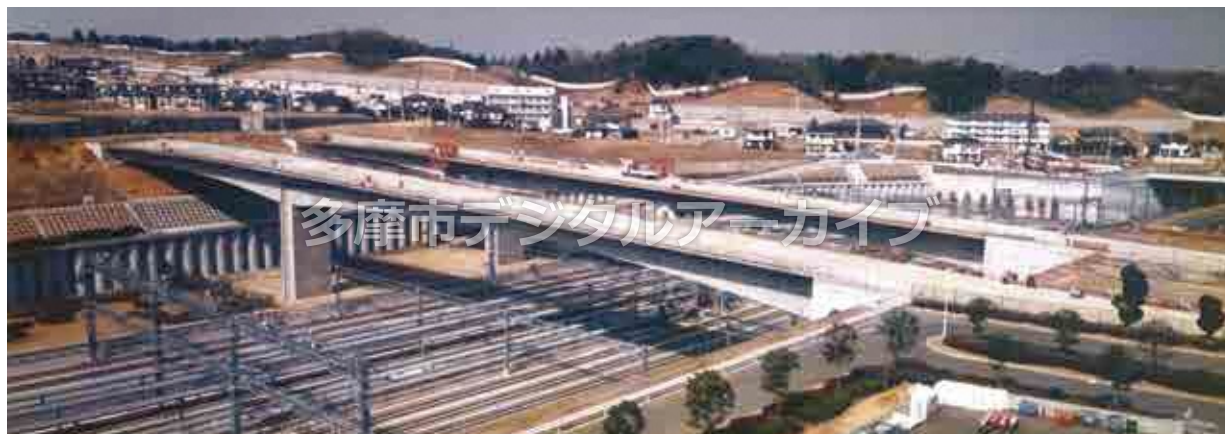
喜多見検車区唐木田出張所と建設中の唐木田大橋 1991（平成3）年3月
