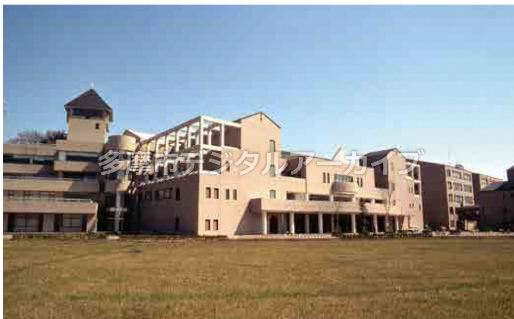
多摩大学 1989(平成元)年2月
