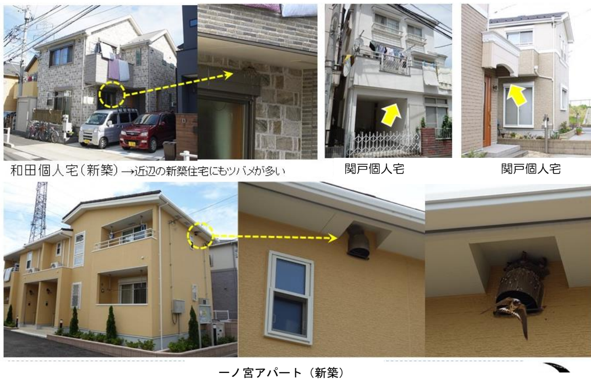
図 5-13 一戸建てや集合住宅(アパート)での営巣状況(2017)
