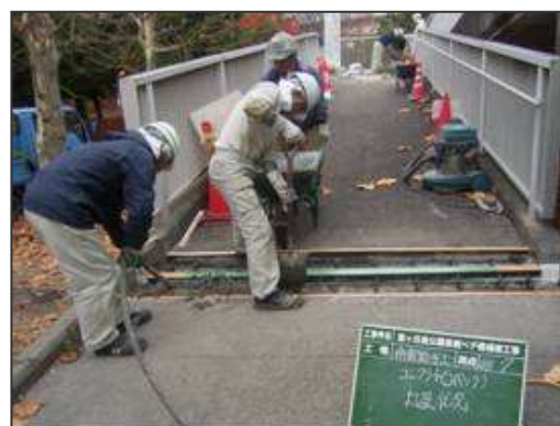
橋りょうの補修工事②
