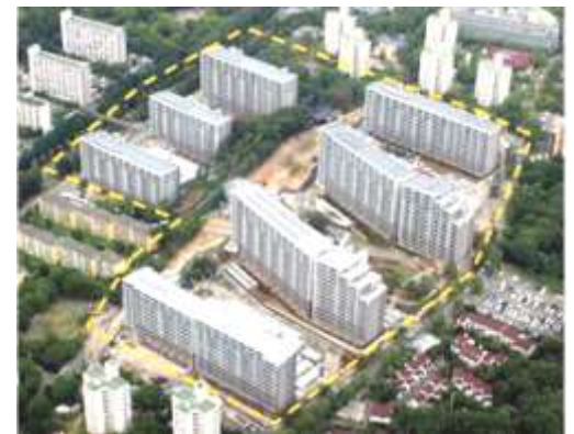
建替えが終了した諏訪2丁目住宅 (平成25(2013)年10月)
