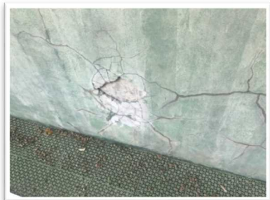
庭球場壁打ち背面のひび割れ・コンクリート基礎の剥離
