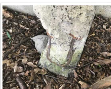
庭球場壁打ち背面のひび割れ・コンクリート基礎の剥離
