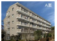
《外断熱改修の実施》 （エステート貝取2-2）
