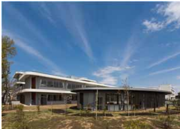
建替を行った多摩第二小学校①（多目的ホールと校舎）
