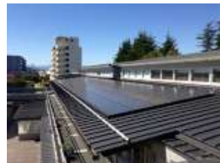
多摩第一小学校の太陽光発電
