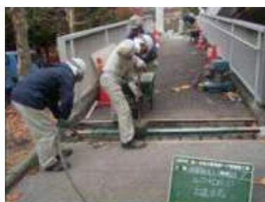
橋りょうの 補修工事
