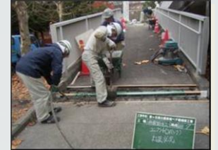
橋りょうの補修工事
