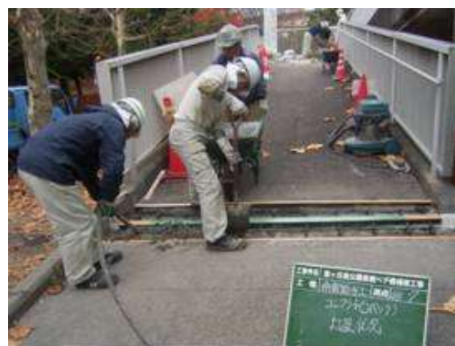
橋りょうの補修工事②
