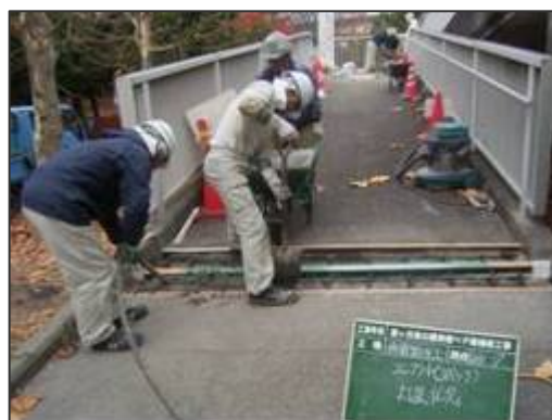
橋りょうの補修工事②
