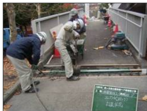
橋りょうの補修工事②
