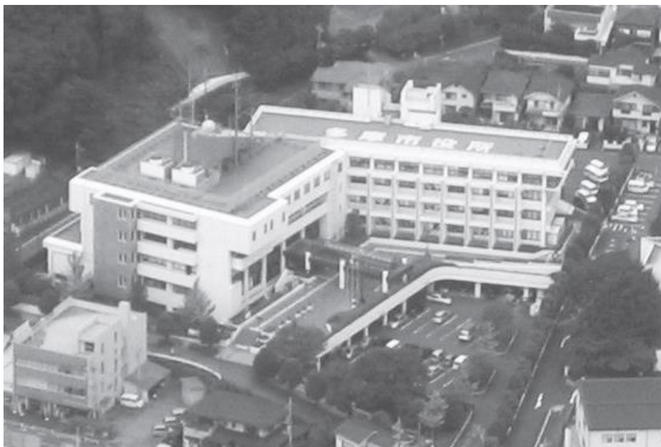
【ヘリサインの設置例・・・場所：多摩市役所屋上】
