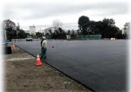
路盤工事を施工中の多摩東公園庭球場 A 面付近
