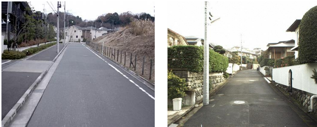
写真-3 生活道路【左：主要な生活道路、右：地区内交通のための生活道路】
