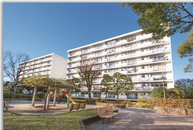
多摩ニュータウン内に多数供給されている公的賃貸住宅
