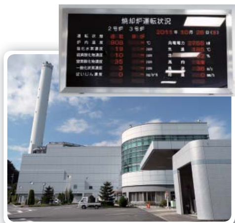
多摩清掃工場の排熱を利用して発電を実施
