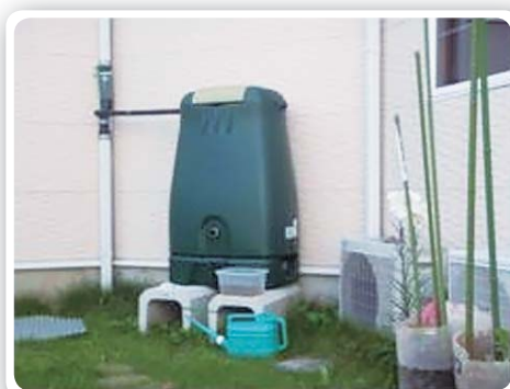
家庭に設置された雨水貯留タンク
