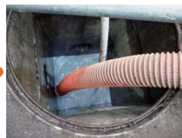
清掃作業の様子
