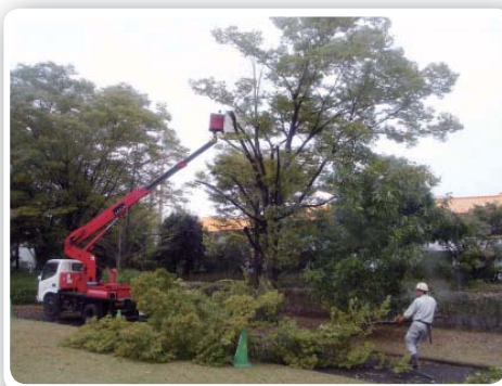
高所作業車を利用した樹木の管理作業
