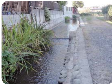
一ノ宮生産緑地区の水路
