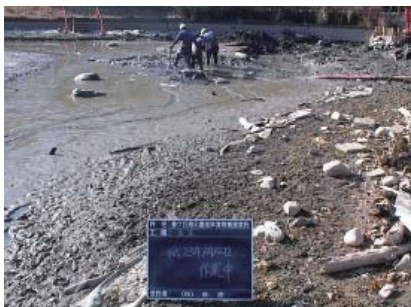
専門業者による池の浚渫作業
