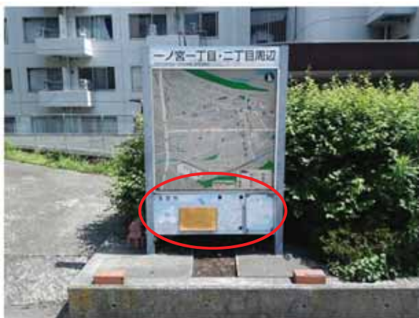
案内サイン、誘導サインの多くで塗装の劣化が見られる。
