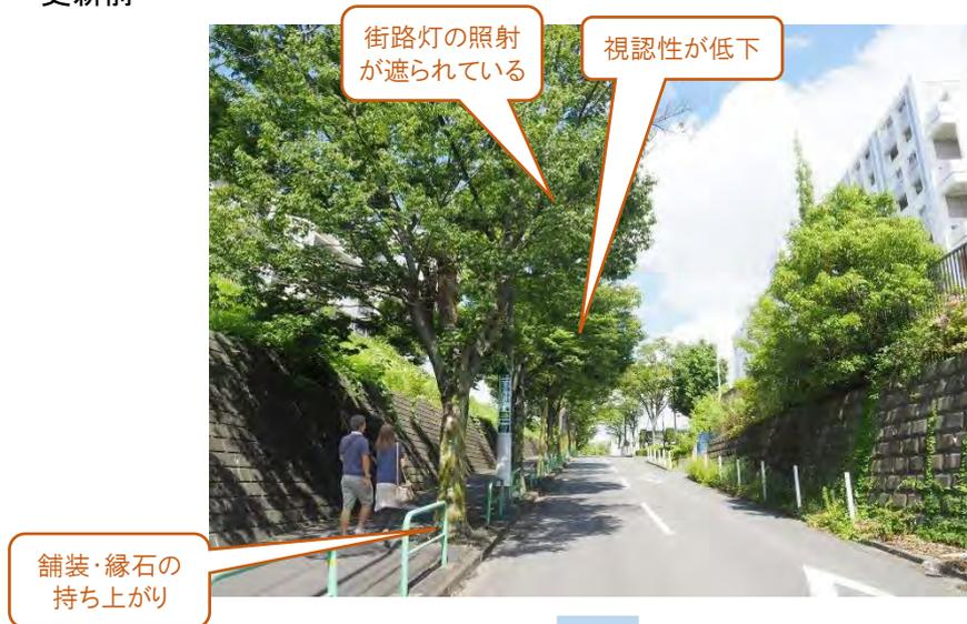
大径木化が進み、根上がりによって舗装・縁石を持ち上げている。隣どうしの枝が接触し、街路灯の照射も遮っている。
