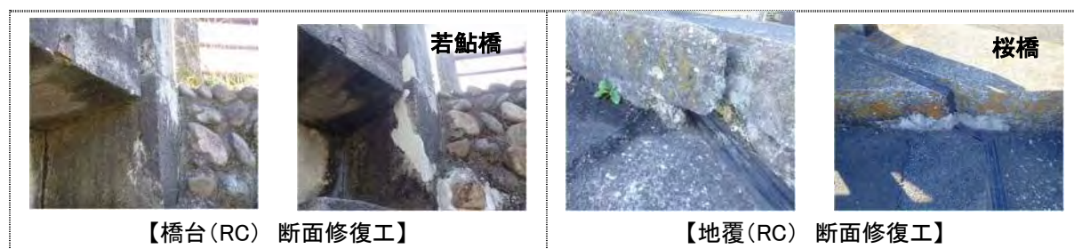
図 3-4. 維持工事（単価契約等）による補修例（再掲）
