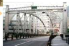
写真-7 南高橋 旧両国橋の材料を 利用し昭和7年竣工
