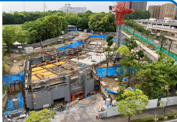
▲ ココリア多摩センター立体駐車場から撮影(5 月下旬)
