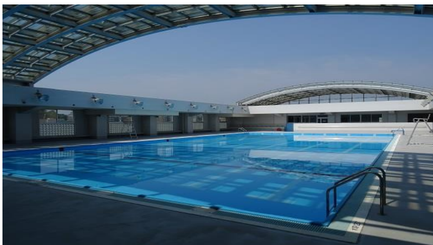
多摩中学校 可動式屋根のプール（体育館棟）
