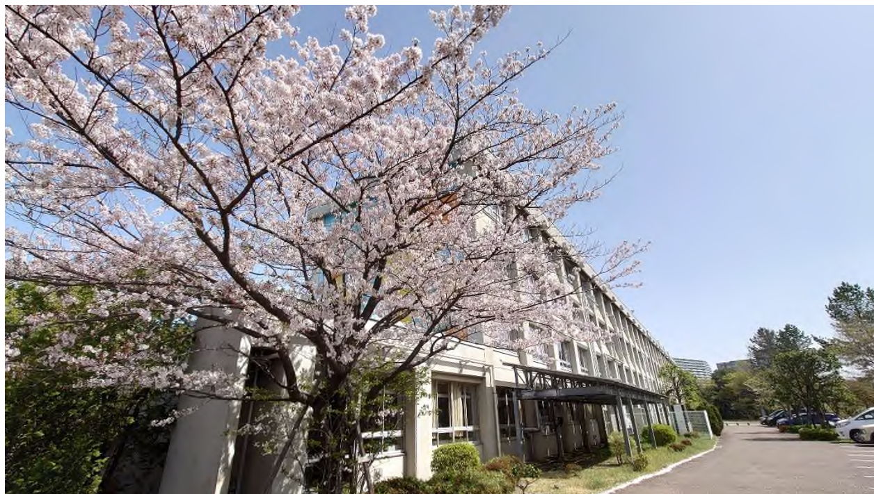
多摩永山中学校 校舎
