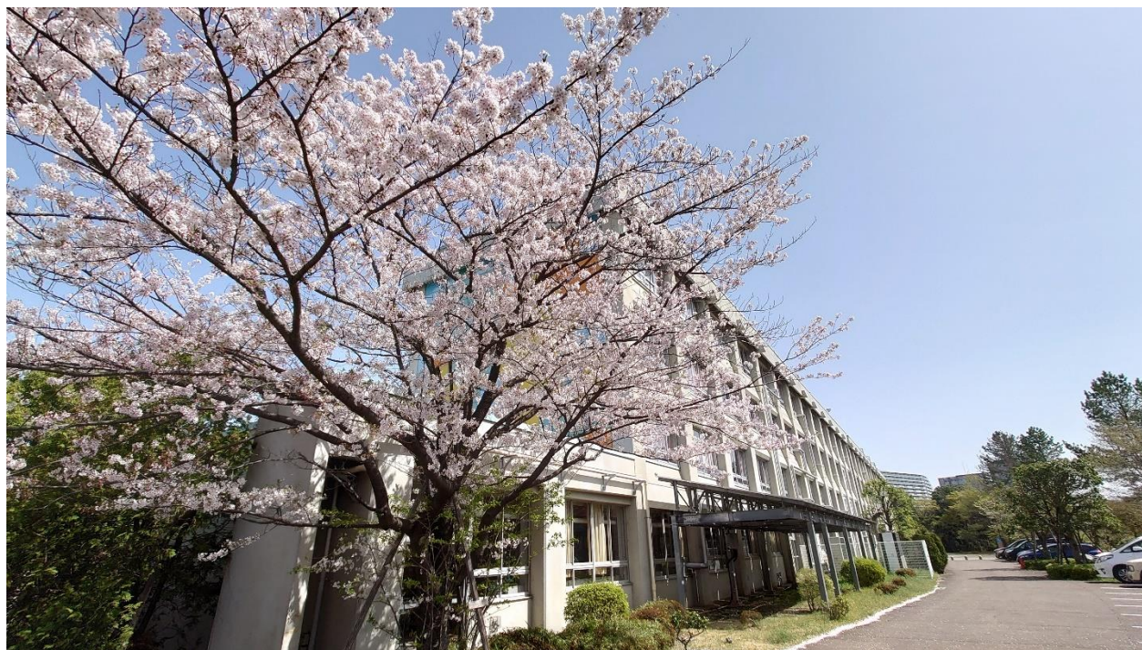
多摩永山中学校 校舎
