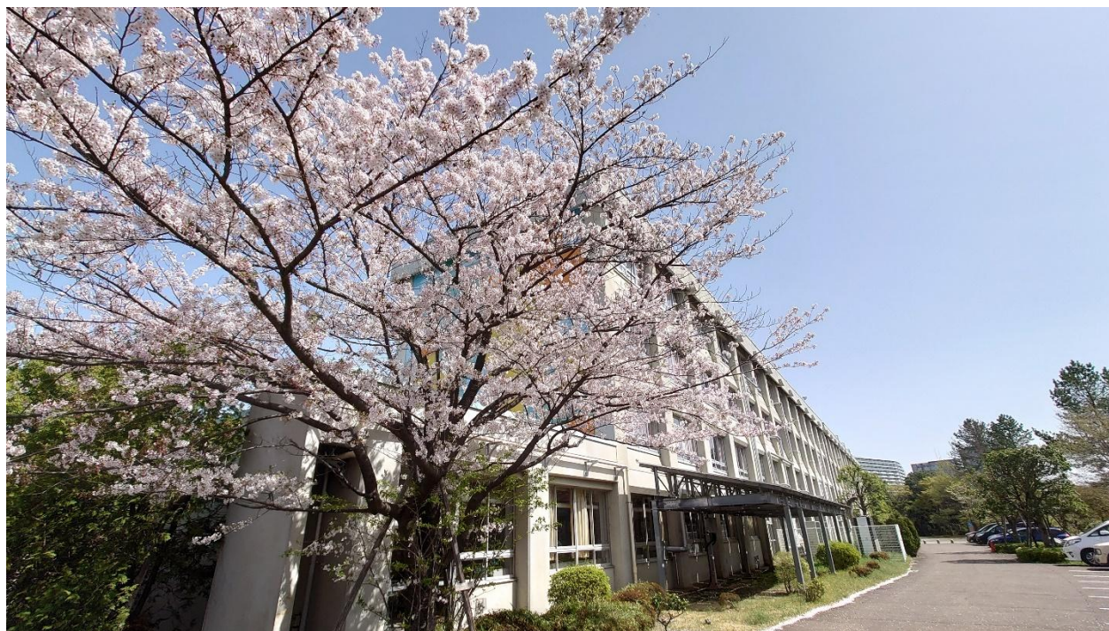
多摩永山中学校 校舎
