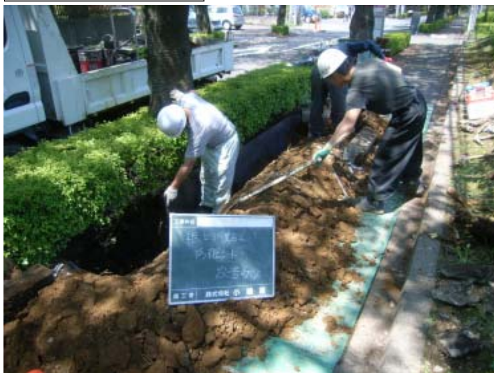
防根シート設置作業状況
