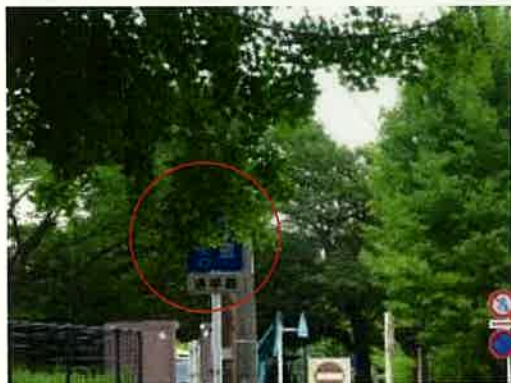
道路標識の視認阻害
