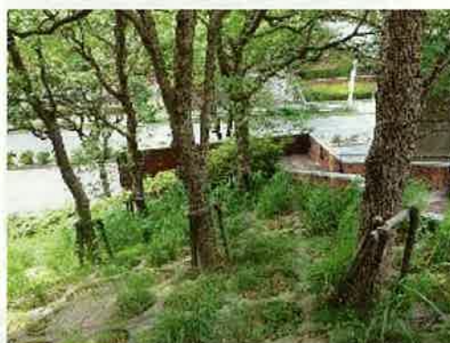
取り残された支柱
