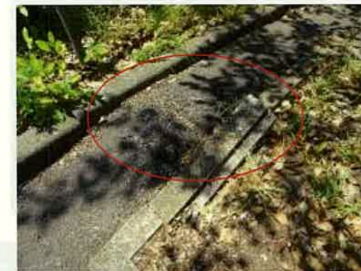
根上り縁石による 歩行性低下
