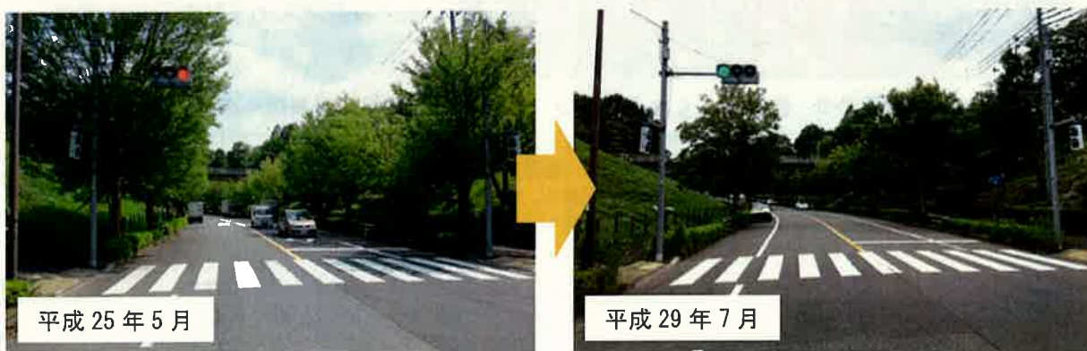
図 2-7 現行プラン策定後の取組 (諏訪の谷通り)
