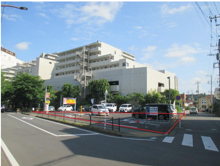
行為制限解除後の状況
