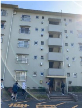
見学住棟外観
