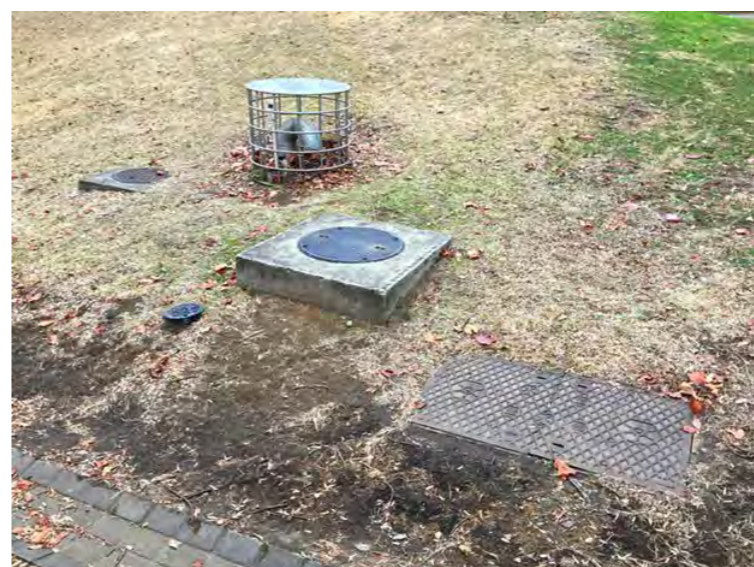
⑭ 歩専道から、敷地内西側の水道/スチーム引込み。
