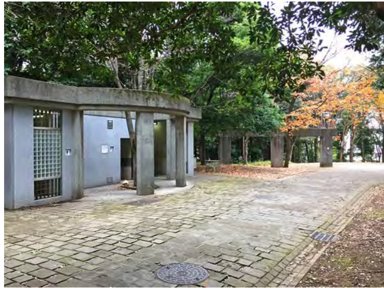
20 敷地内の野外トイレ前、北方面の園路と敷地。
